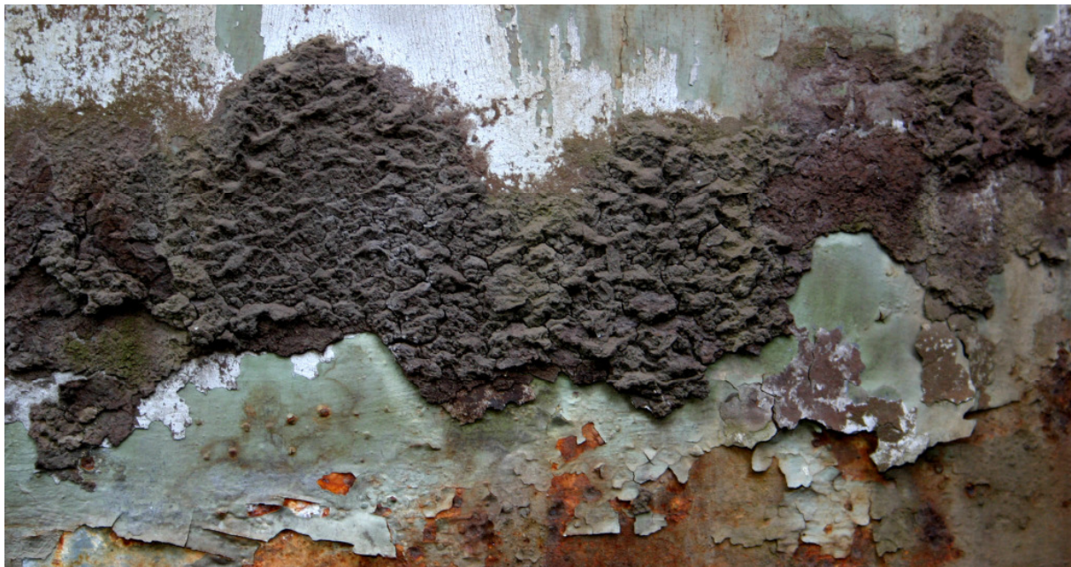
Rost in der alten Völklinger Hütte
