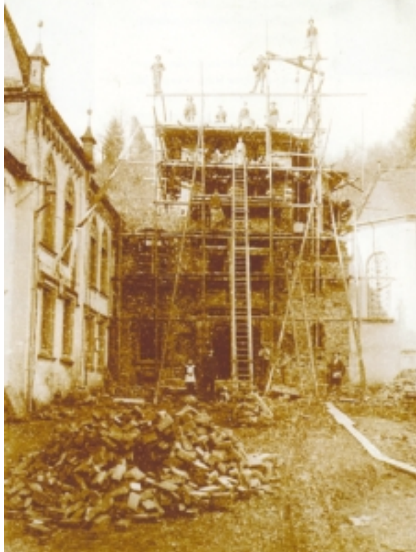
Schloss Dagstuhl wird 1906 erweitert. Rizza von Louisenthal lässt den Schlossturm und die Gruft erbauen. Die in Wadern ansässige Baufirma Matthias Barbian übernimmt die Umbauarbeiten. Der Schlosshof dient vorübergehend als Bauschuttablage und Steindepot. Holz wird herangeschafft, ein riesiges Gerüst aus hohen Baumstämmen und Brettern errichtet. Tollkühn jonglieren die Arbeiter darauf herum. Die mutigsten posieren sogar für ein Foto ohne Halteseile an den höchsten Stellen.
